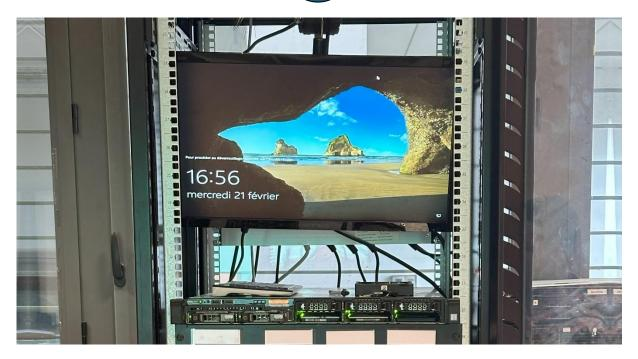
Le monitor nous permet de surveiller nos différents serveurs à l'aide d'un clavier possédant un trackpad avec lequel nous pouvons contrôler et administrer nos machines.
